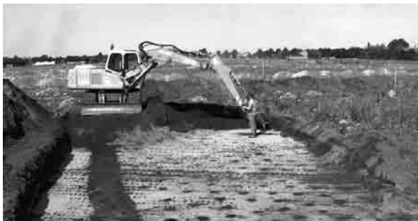
Afb. C: Paalsporen van de landweer in de Piekenhoef.
